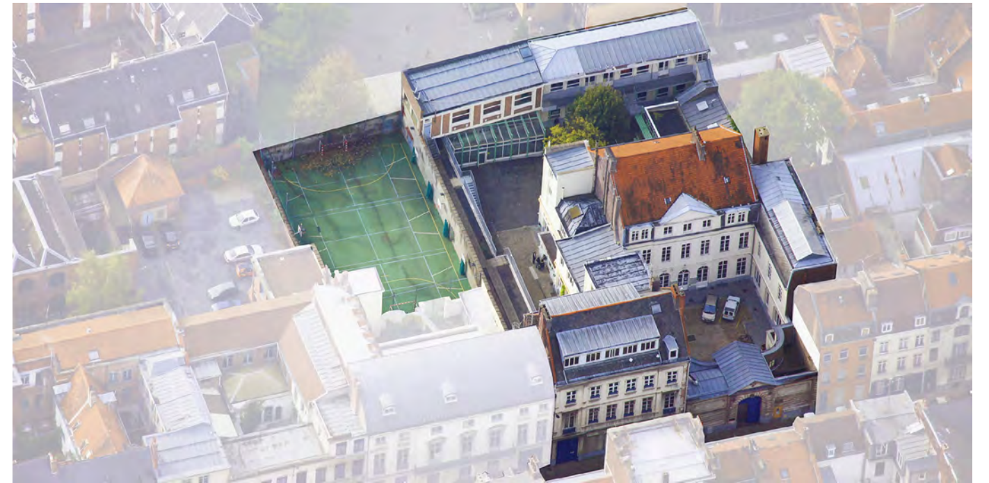
Vue aérienne des espaces concernés par le projet architectural de l'Institut pour la photographie
