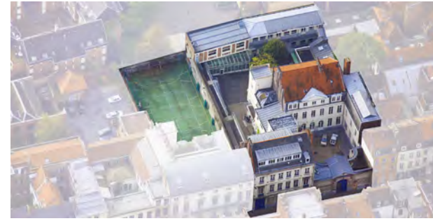
Vue aérienne des espaces concernés par le projet architectural de l'Institut pour la photographie
